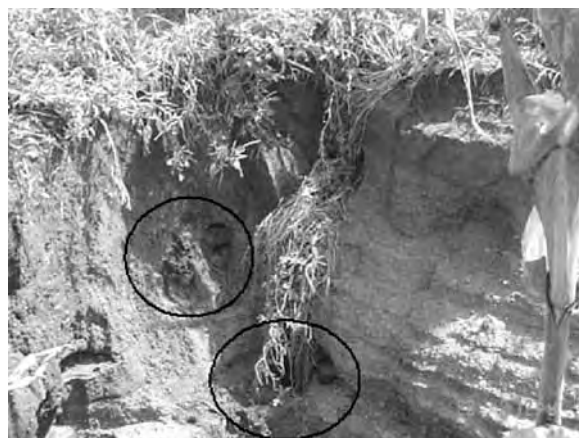
Foto 3. En esta imagen se han destacado los macro-poros en las paredes de la grieta del 27/09/2004. Fuente: Trabajo de campo del Cuerpo Académico Atlas Ambientales y Riesgos, hoy Cuerpo Académico SI-Riesgos (CUCSH-CU-Valles-UDG, 2004).
