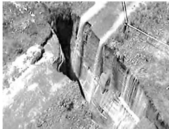
Foto 1. Segmento central de la grieta del 29 de junio de 2004, se puede observar la cascada de agua que cae en la grieta. Fuente: Trabajo de campo del Cuerpo Académico Atlas Ambientales y Riesgos, hoy Cuerpo Académico SI-Riesgos (CUCSH-CU-Valles-UDG, 2004).
